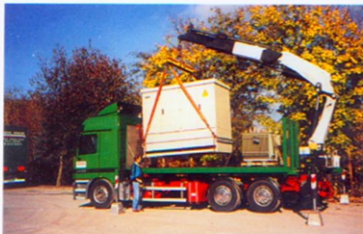
Statt Traföhäuschen gibt es heute Kompaktstationen. Der Ladekran schafft bei zehn Metern Auslage noch beachtliche 3,5 Tonnen
