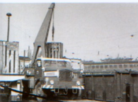
Am Bahnhof herrschte stets reges Treiben. Hier verlädt der Autodrehkran Trafos nach Wismar für den Weitertransport nach Syrien
